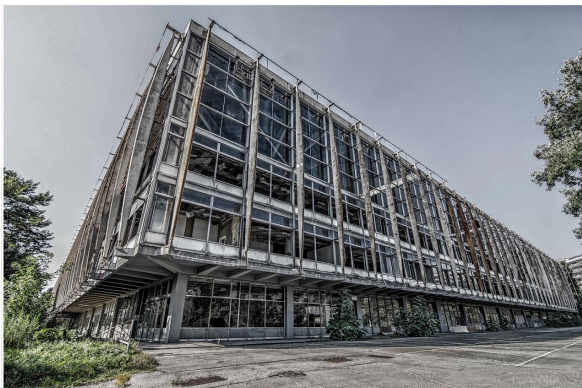
Stato attuale dell'ex Palazzo del Lavoro di Nervi
